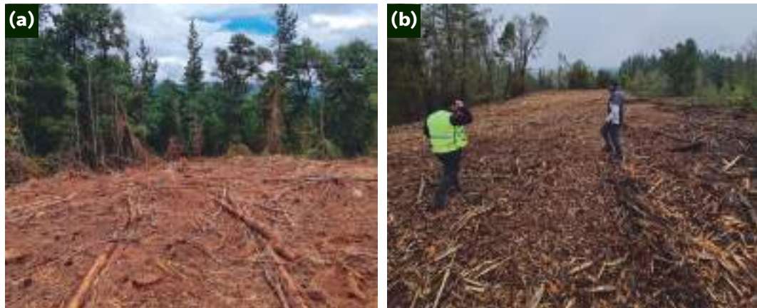
Figura 19: (a) Sitio de restauración habilitado y (b) el mismo sitio con una capa de astillas resultante del triturado de aromo.
