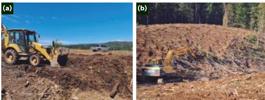
Figura 18: (a) Trabajos de retroexcavadora para el retiro de material leñoso en exceso y (b) trabajo de retroexcavadora para la homogenización de altura del triturado.
